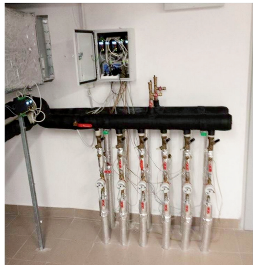
Ryc. 5. Kolektory układu pionowych wymienników gruntowych
