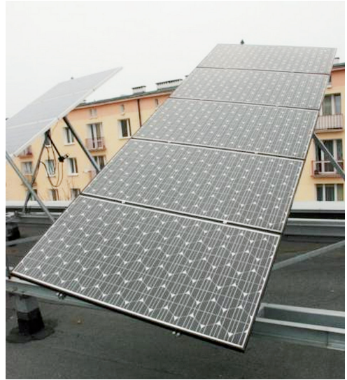
Ryc. 7. Panel fotowoltaiczny z modułami Sanyo HIT
