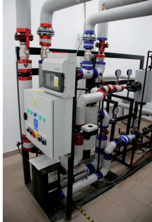
Ryc. 4. Widok jednofunkcyjnego, kompaktowego węzła firmy Danfoss
